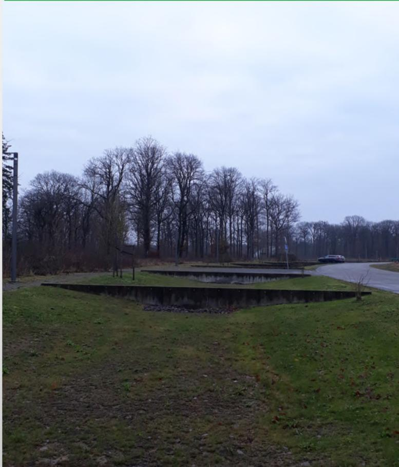
= Sorte de **fossé peu profond et large, végétalisé**, avec des rives en pente douce, qui recueille provisoirement de l'eau de ruissellement, soit pour l'évacuer via un trop-plein, soit pour l'évaporer ou pour l'infiltrer sur place
