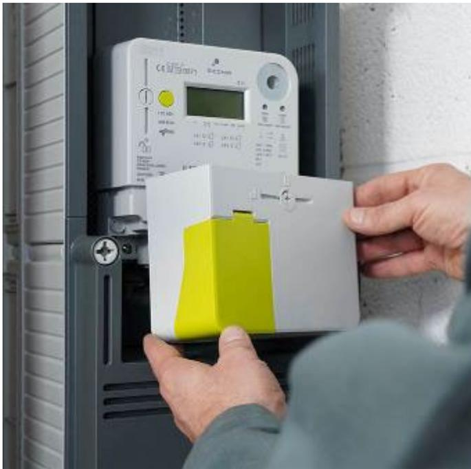
Le compteur à budget est remplacé par un compteur communicant à fonction de prépaiement (électricité et gaz).
